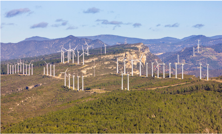
Parque eólico de Trucafort, unos de los primeros de Cataluña.
