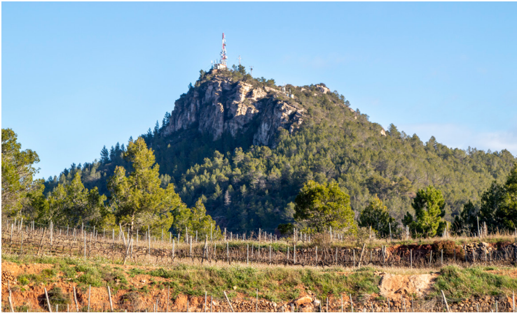
Torres de Altafalla.
