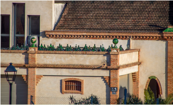
Detalle de la azotea de la Cooperativa Falset Marçà.
