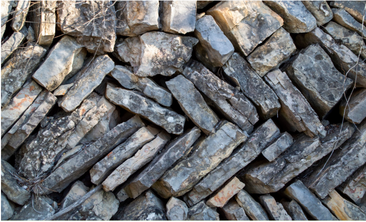
La tècnica de l'espigat en els murs de pedra seca.
