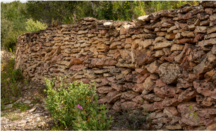
Marges de pedra seca.
