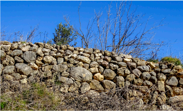
Murs de pedra seca per crear terrasses de conreu.
