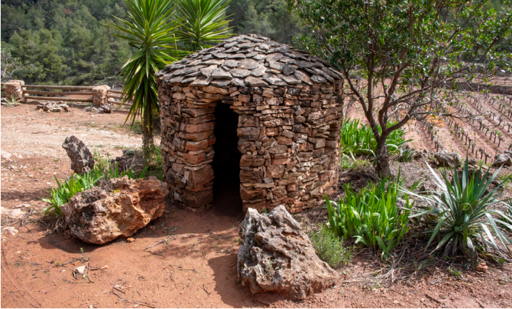
Aljibe de recogida de agua de lluvia, Caseta de la Vall.
