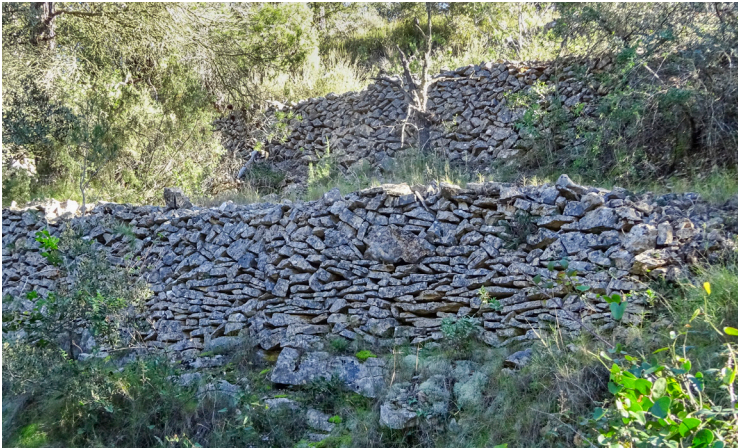
Muros de piedra seca.
